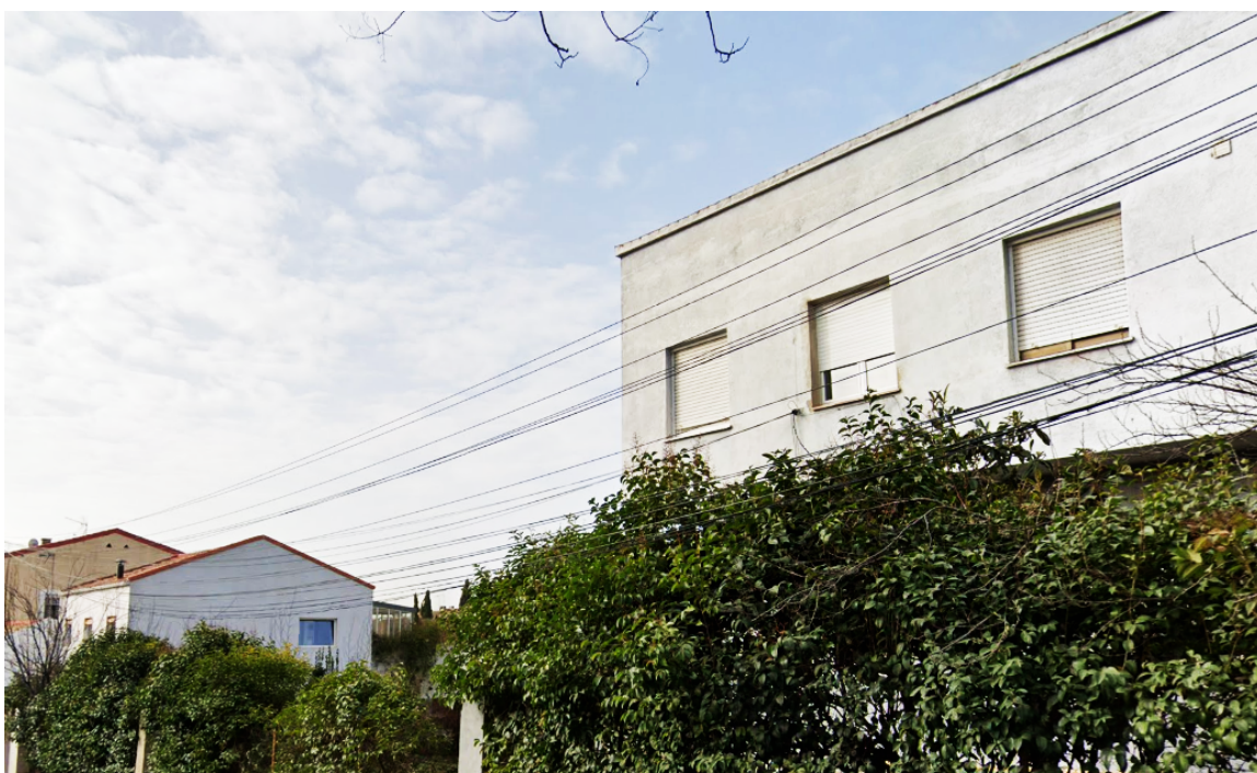
Un alt aspect unde pot fi văzute ambele clădiri.
