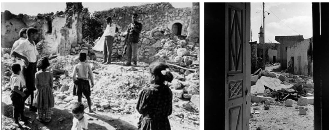
Qalqilya: aspect al distrugerilor din 1967
